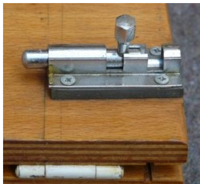
Abb. 19 Riegel mit Unterlegplatte unter Brett
