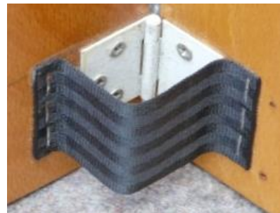
Abb. 22 Gurtband als Scharnierabdeckung
